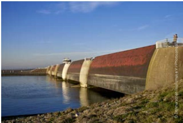
Das Eidersperrwerk ist ein technisches Bollwerk, das seit 1973 die Entwässerung der Flussebene sichert. Fünf riesige Doppeltore von je 250 Tonnen Gewicht wirken wie Wellenbrecher und schützen so die Marsch flussaufwärts vor der Naturgewalt einer Sturmflut. Die 25 Meter lange Schleuse ermöglicht es Fischkuttern, Ausflugsschiffen und Privatbooten, zwischen Eider und Nordsee zu pendeln.
